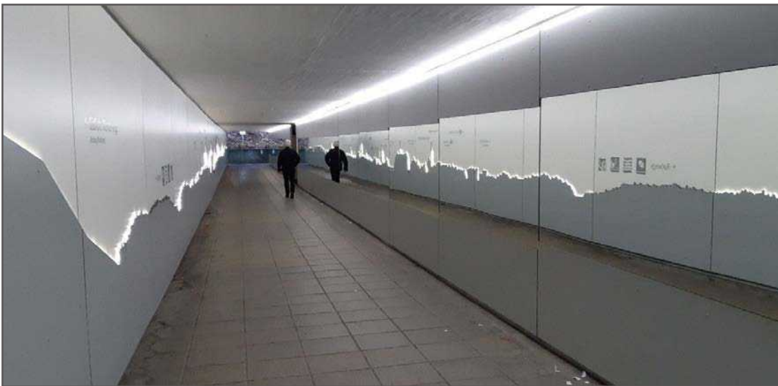
Abbildung 57: Aufwertung Bahnunterführung, Beispiel aus Lauf, Bahnhof r. d. Pegnitz
