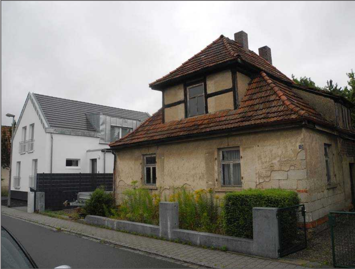
Abbildung 7: Kontraste der Bausubstanz
